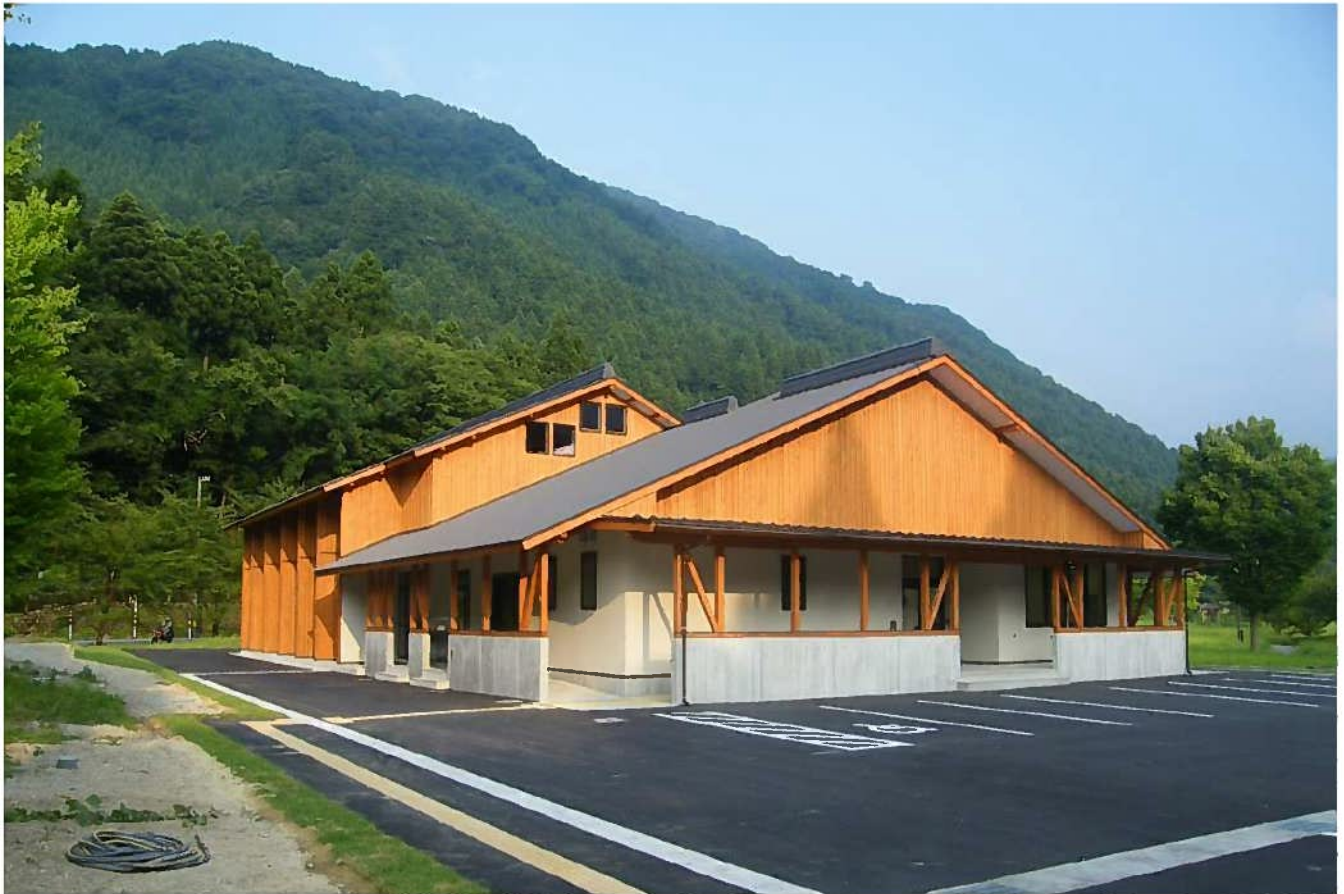
施設外観。明るい彩色の建物に、雁木によって入り口に誘導される。外壁は県産杉の縦張り。屋根は寄下ろし不要な落雪型とし、敷地の広さを活かし地上で機械処理できるようにするなどの配慮がみられる。
