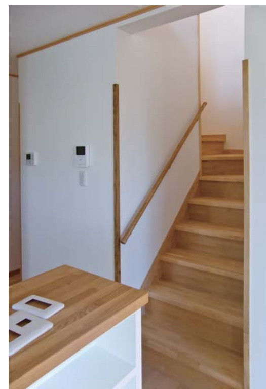
階段ですが、壁のコーナーに木材を取り付けることにより部屋全体が柔らかく感じられるようになっています。
